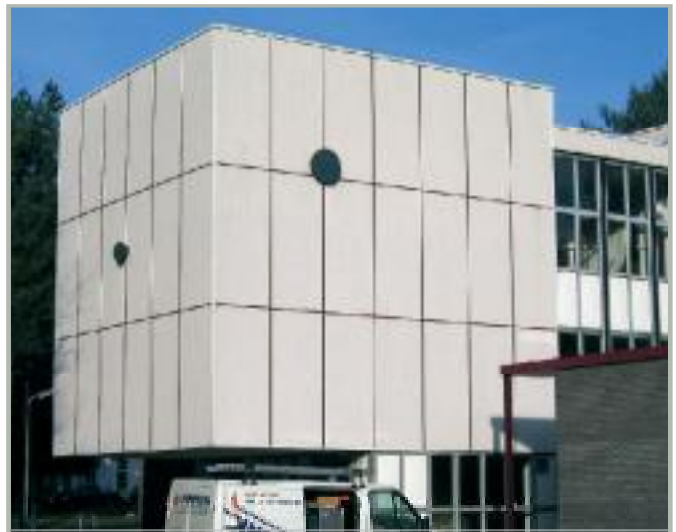
Betonsanierung Laren, NL
